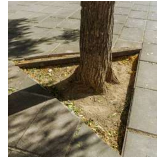
PAVIMENTS DEL PASSEIG
